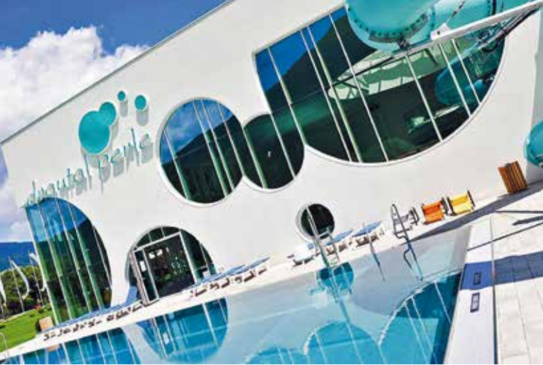
Auf dem Dach der drautal perle errichtet die Stadtgemeinde Spittal ein Sonnenkraftwerk
