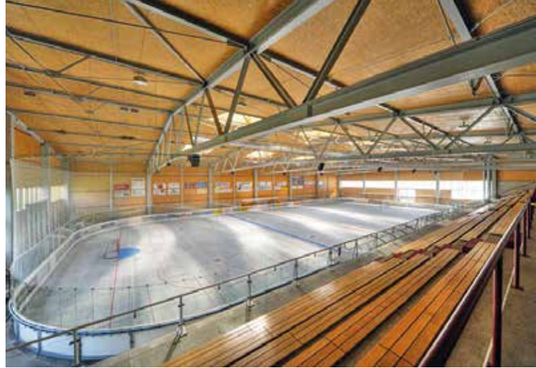
Gemeinsam mit der drautal perle wird die PV-Anlage auf dem Dach der Eissportarena eine jährliche Stromersparnis von 50.000 Euro bringen
