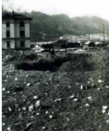
Bombenkrater Eisenbahnersiedlung Carl-Wurmbweg
